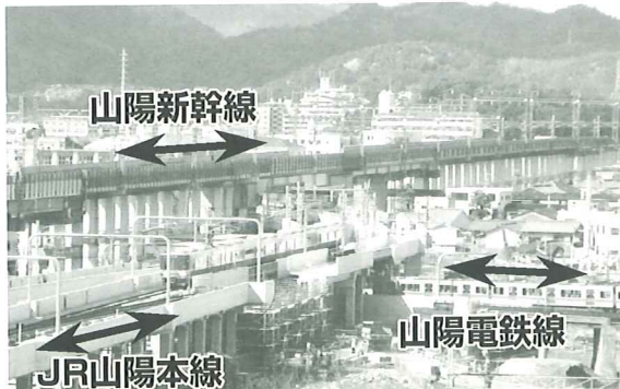
■JR姫路駅付近高架化（JR山陽本線、山陽新幹線、山陽電鉄線の交差箇所）
